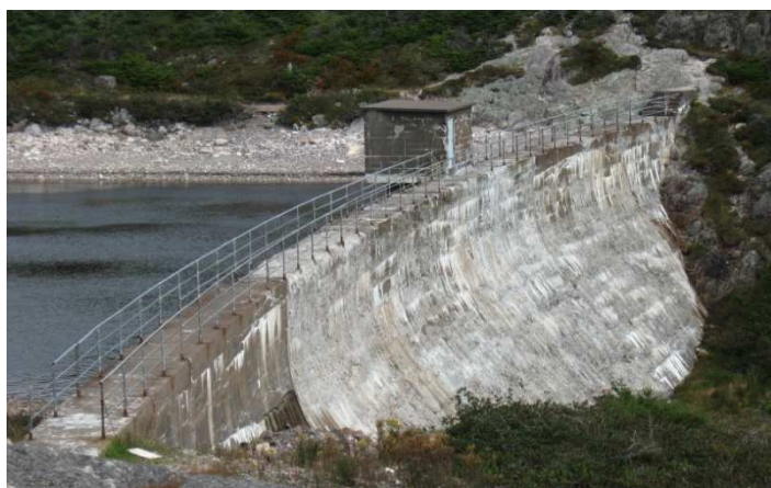
Barrage de la Vigie © Collection privée
