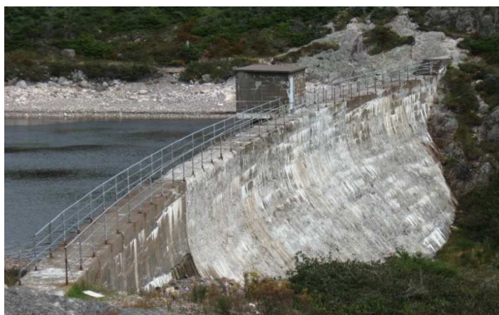
Barrage de la Vigie © Collection privée
