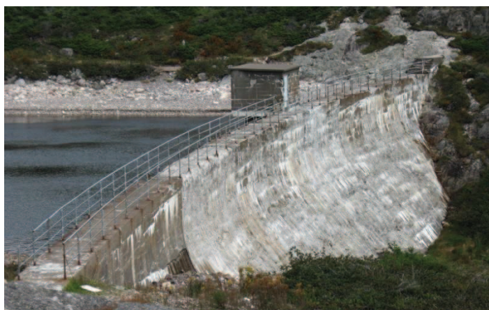
Barrage de la Vigie © Collection privée
